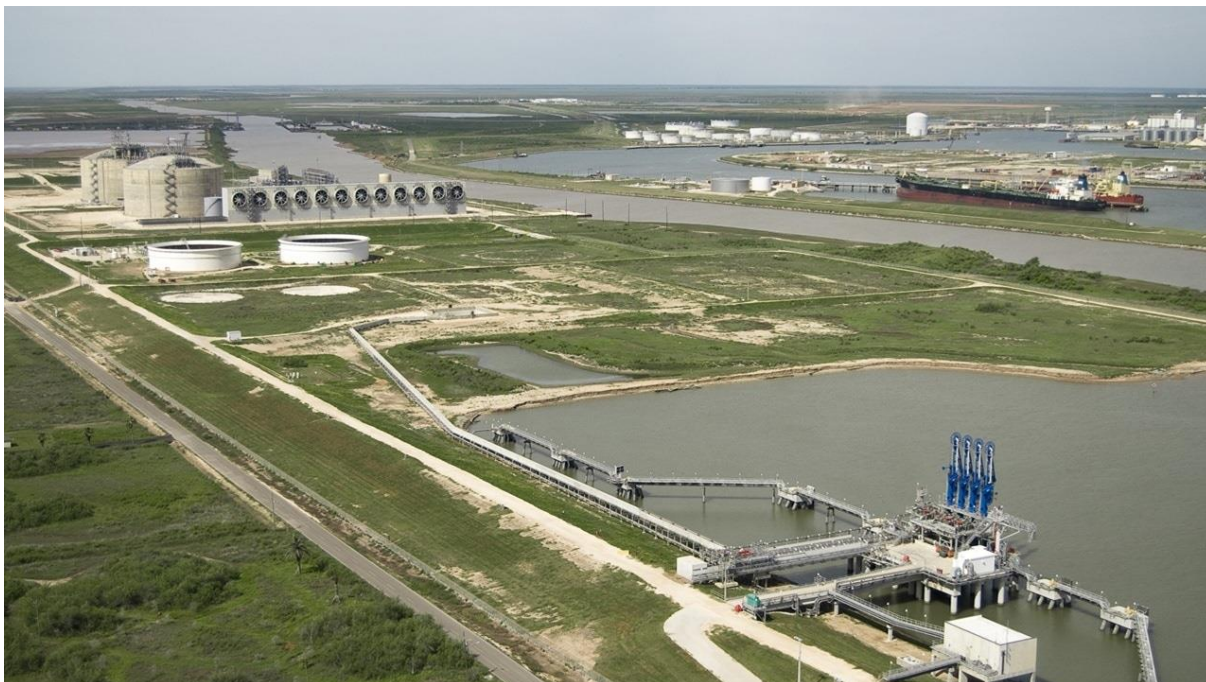
Freeport LNG terminal marine dockCredit: Freeport LNG Development L.P.
